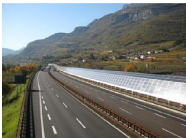
impianto su autostrada (barriera acustica)
