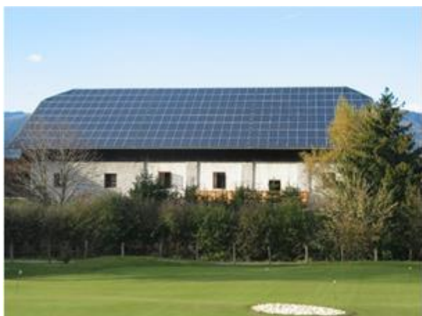
impianto su capannone
