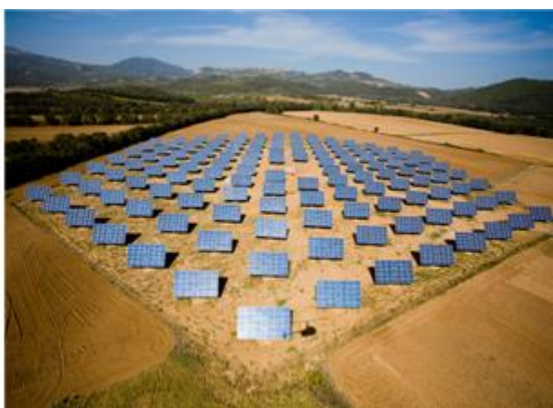
impianto a terra
