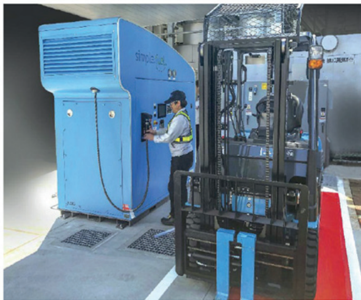
Figura 71 Esempio di stazione compatta e integrata
