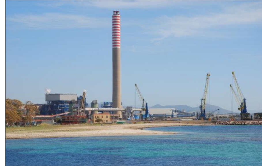
Centrale di Portovesme – 320MW (Portoscuso)
